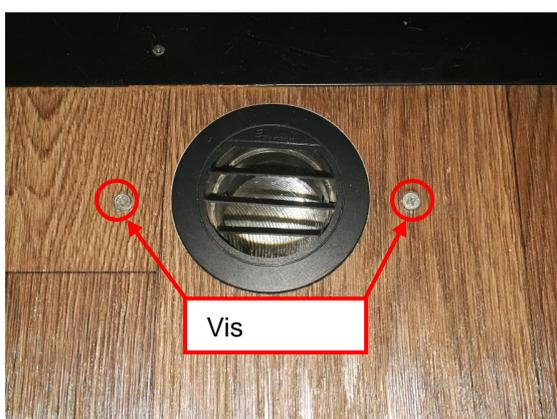
Visser dans le sol les vis à distance des aimants montés et centrées par rapport de la buse d'air chaud se trouvant au sol.
