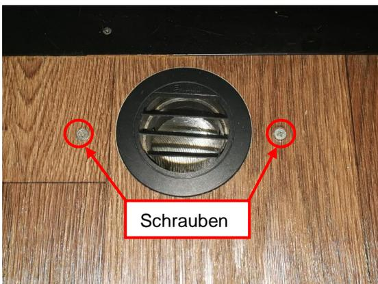
Schrauben im Abstand der montierten Magnete und mittig der am Boden befindlichen Warmluftdüse in den Boden schrauben.
